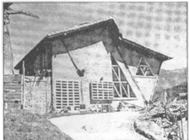
Figura 10. Vista lateral de la vivienda construida.
