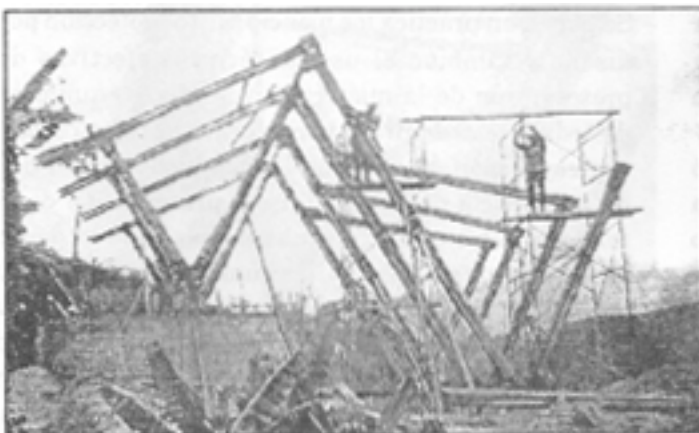
Figura 5. Montaje de los 4 pórticos según topografía.
